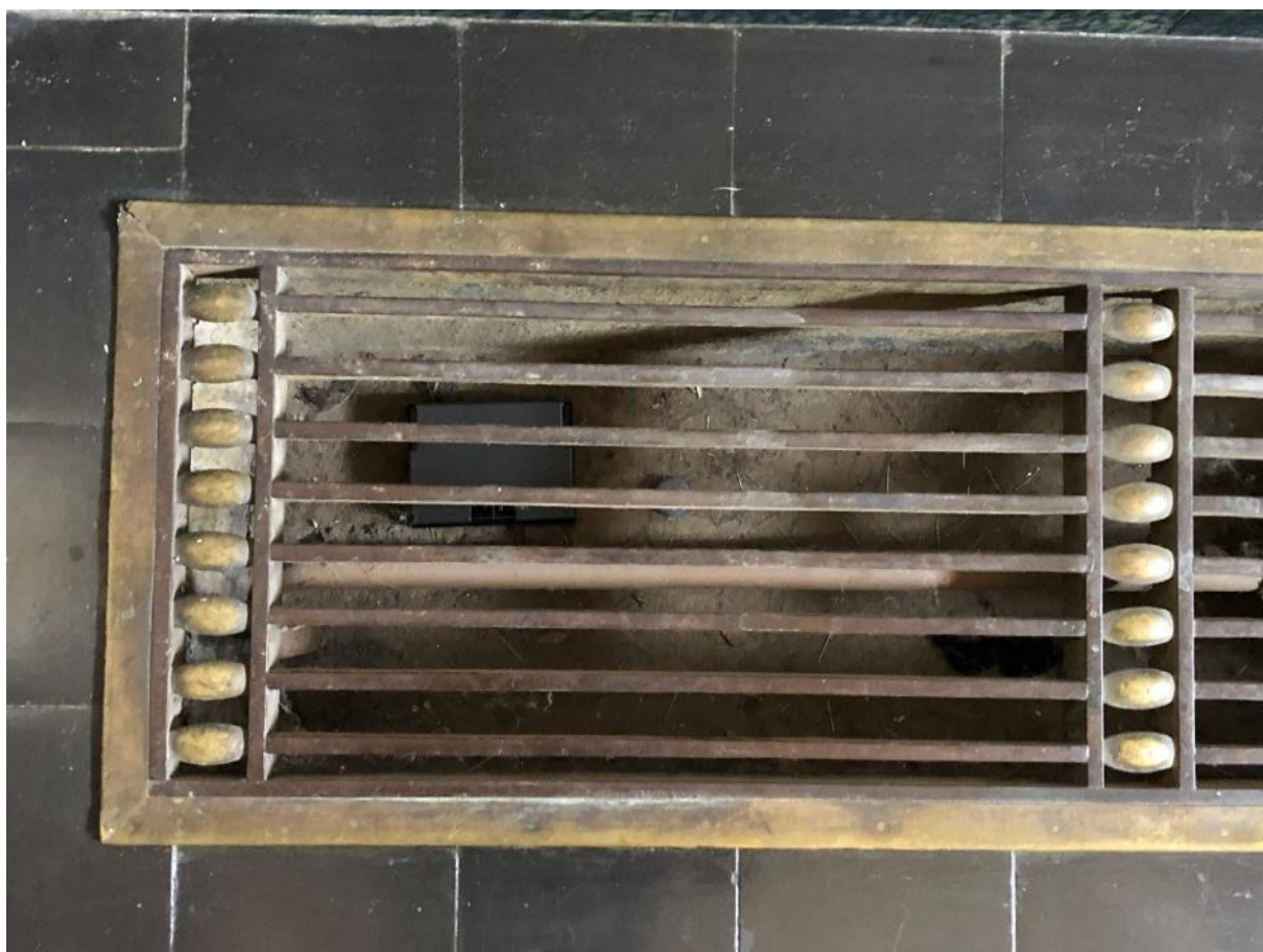
Mřížová konstrukce topení v podlaze
