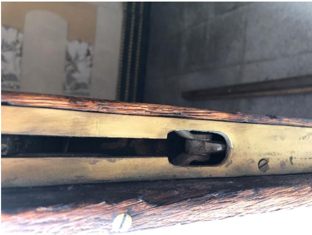
Ulomená páka výsuvného mechanismu ovládání zástrče.
