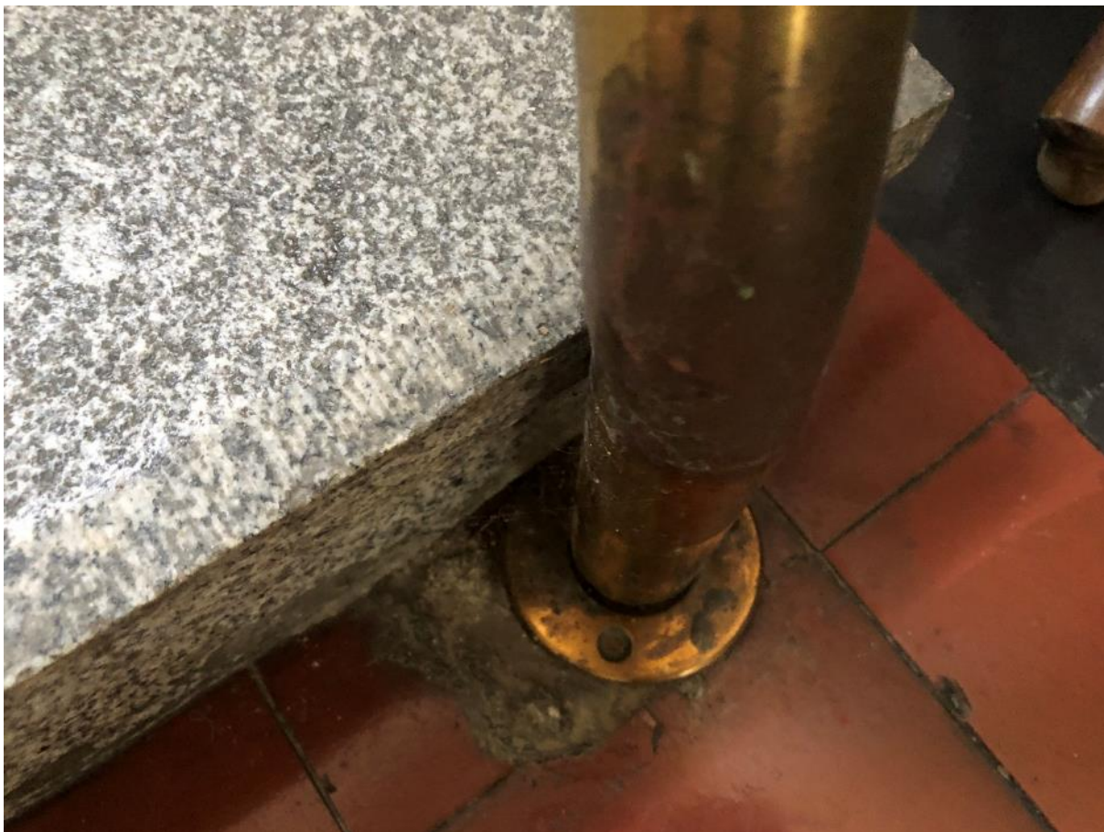
Kotvení nohy trubkového zábradlí pravá strana
