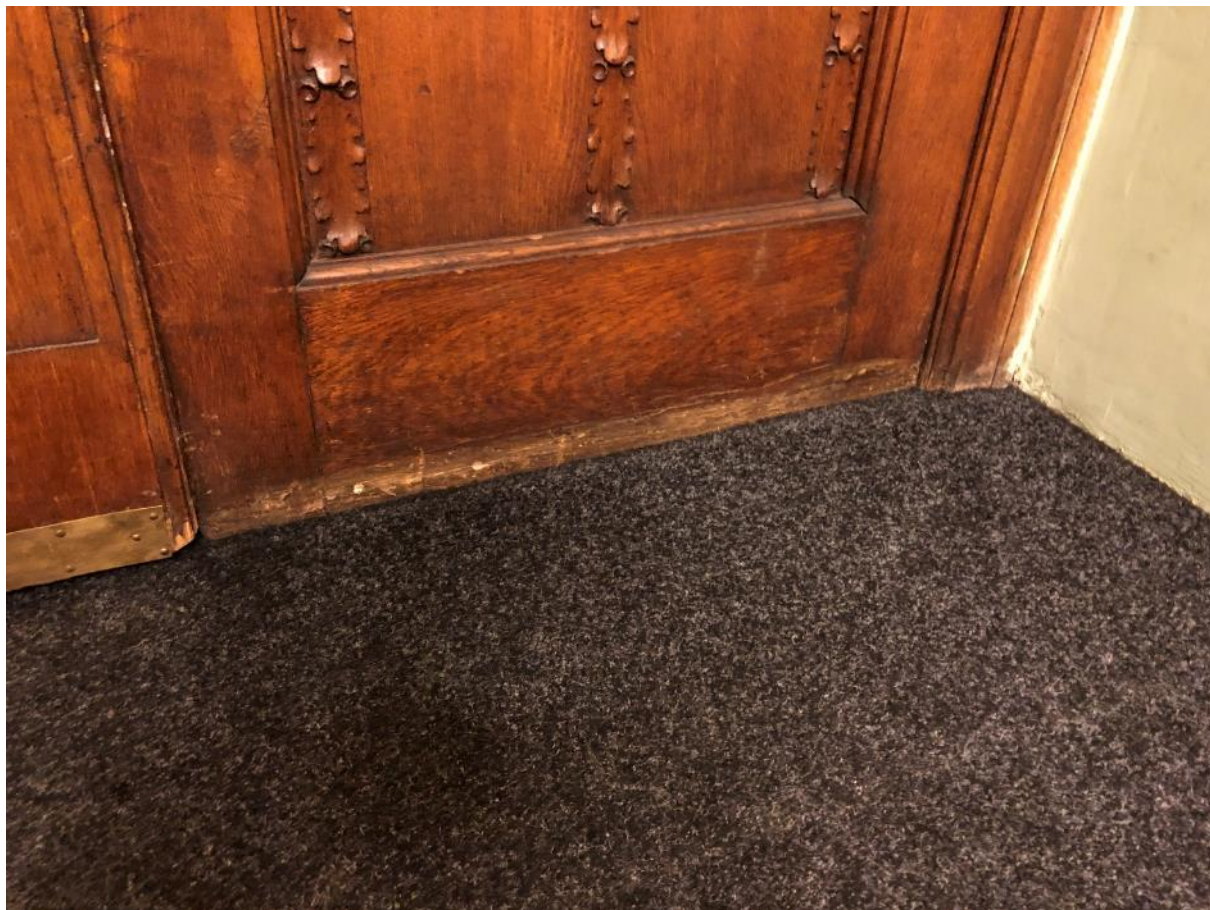
Chybějící mosazný obklad dveří.
