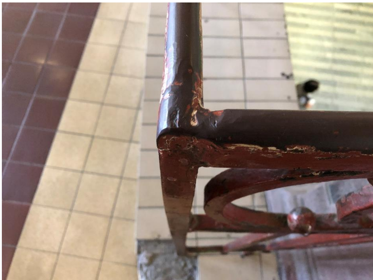
Nevhodně provedená oprava napojení madla.
