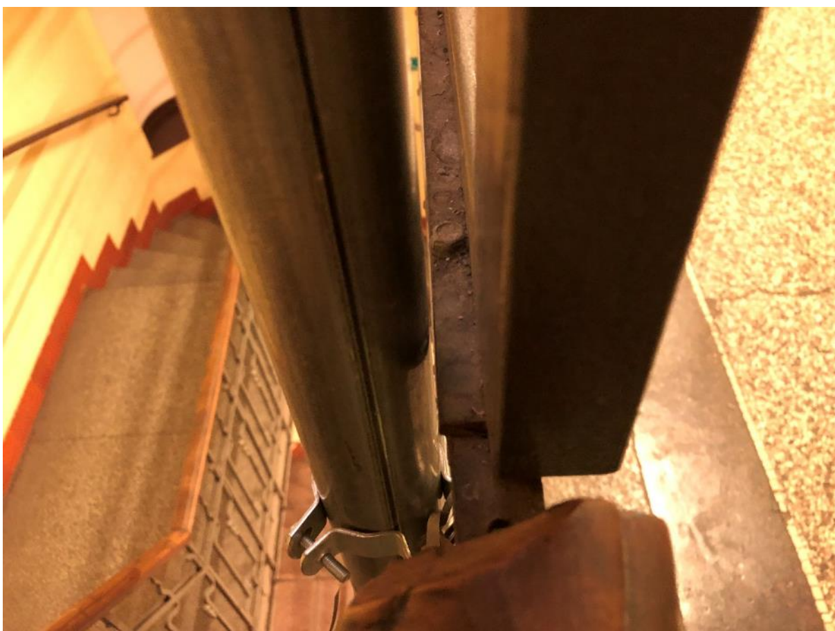
Způsob kotvení novodobé mřížové nástavby
