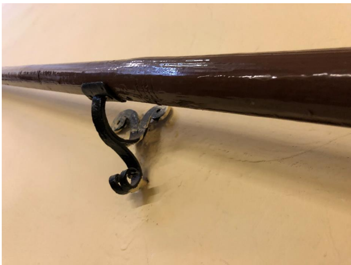
Původní konzolky madla zábradlí
