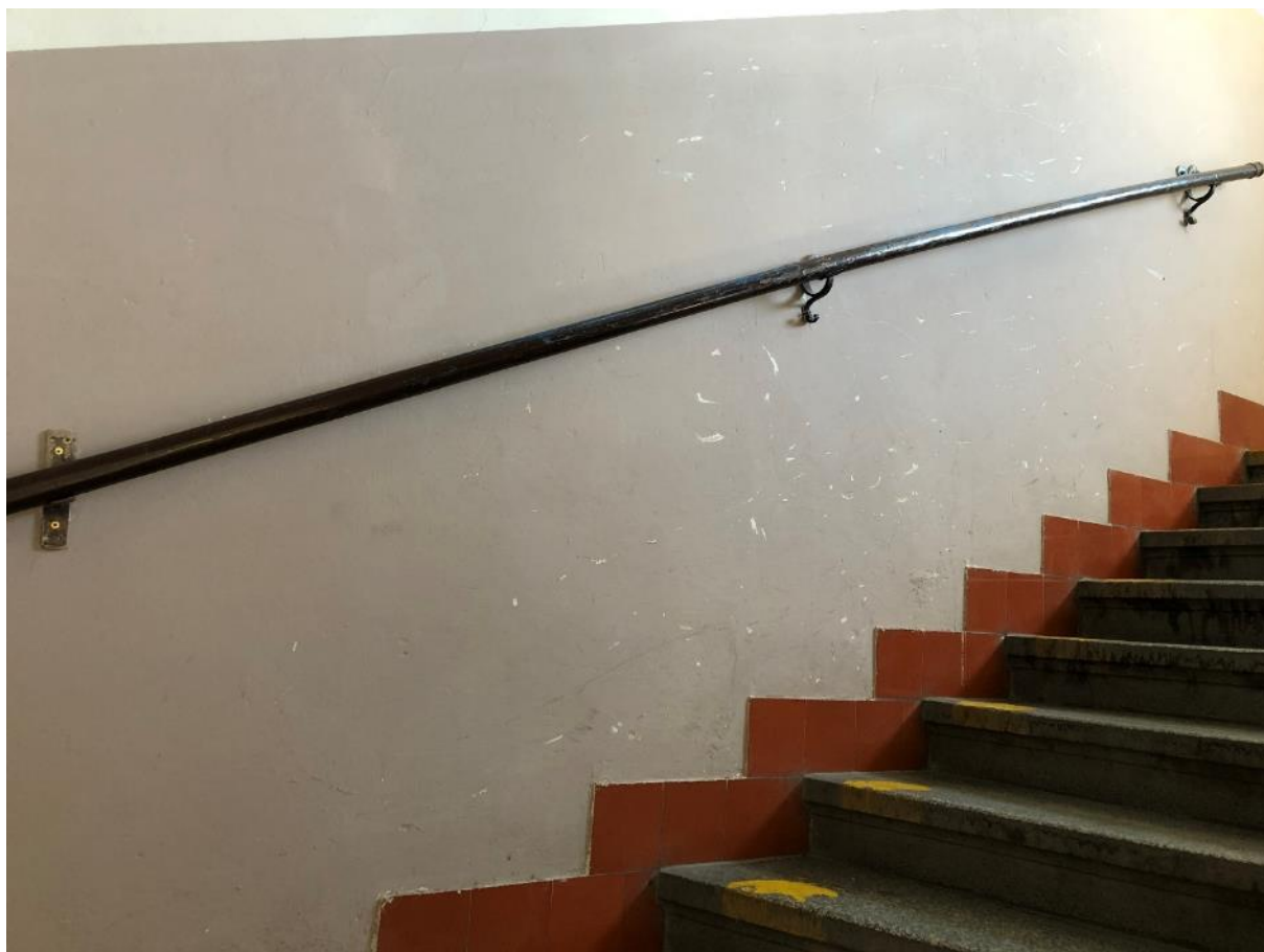
Konzolky úchytů madla vlevo novodobé vpravo původní
