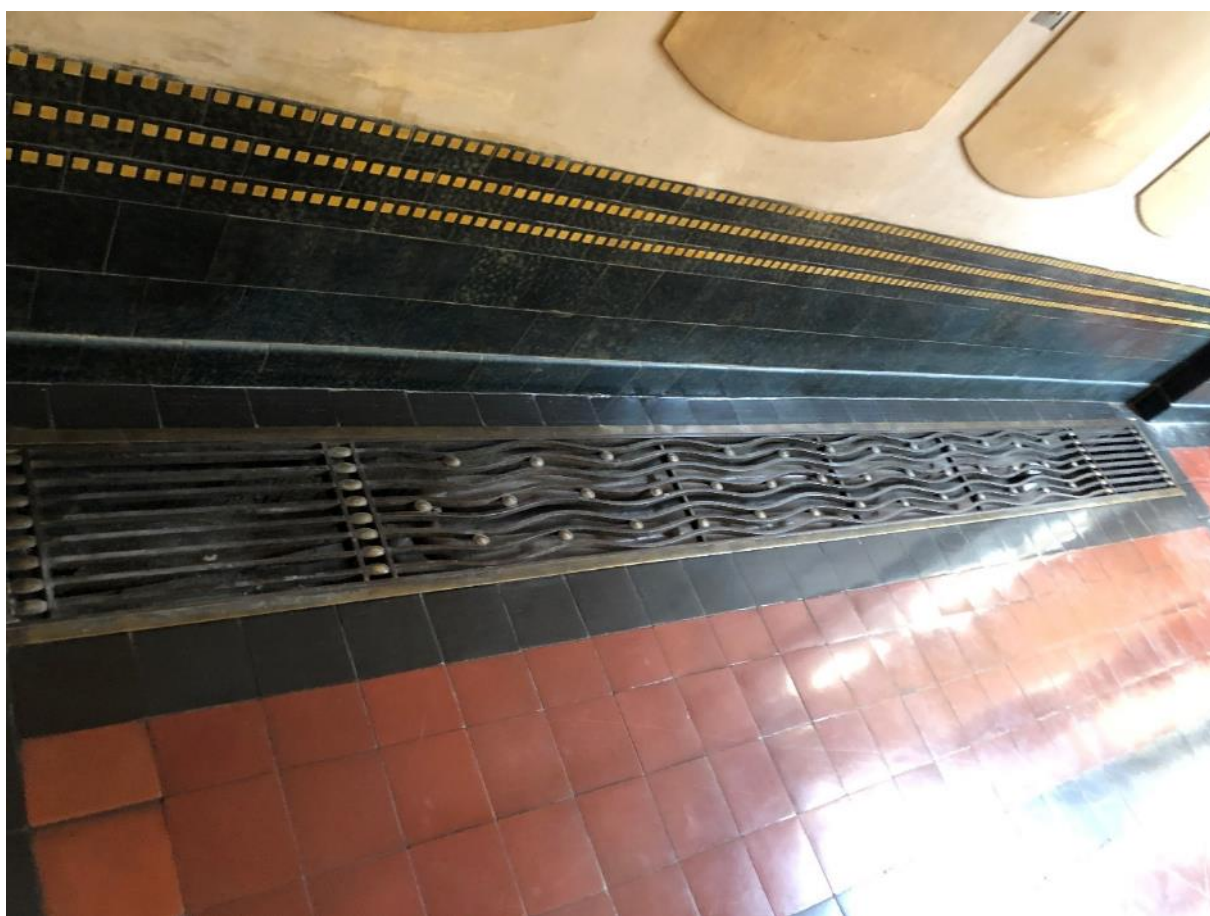
Mřížová konstrukce topení v podlaze
