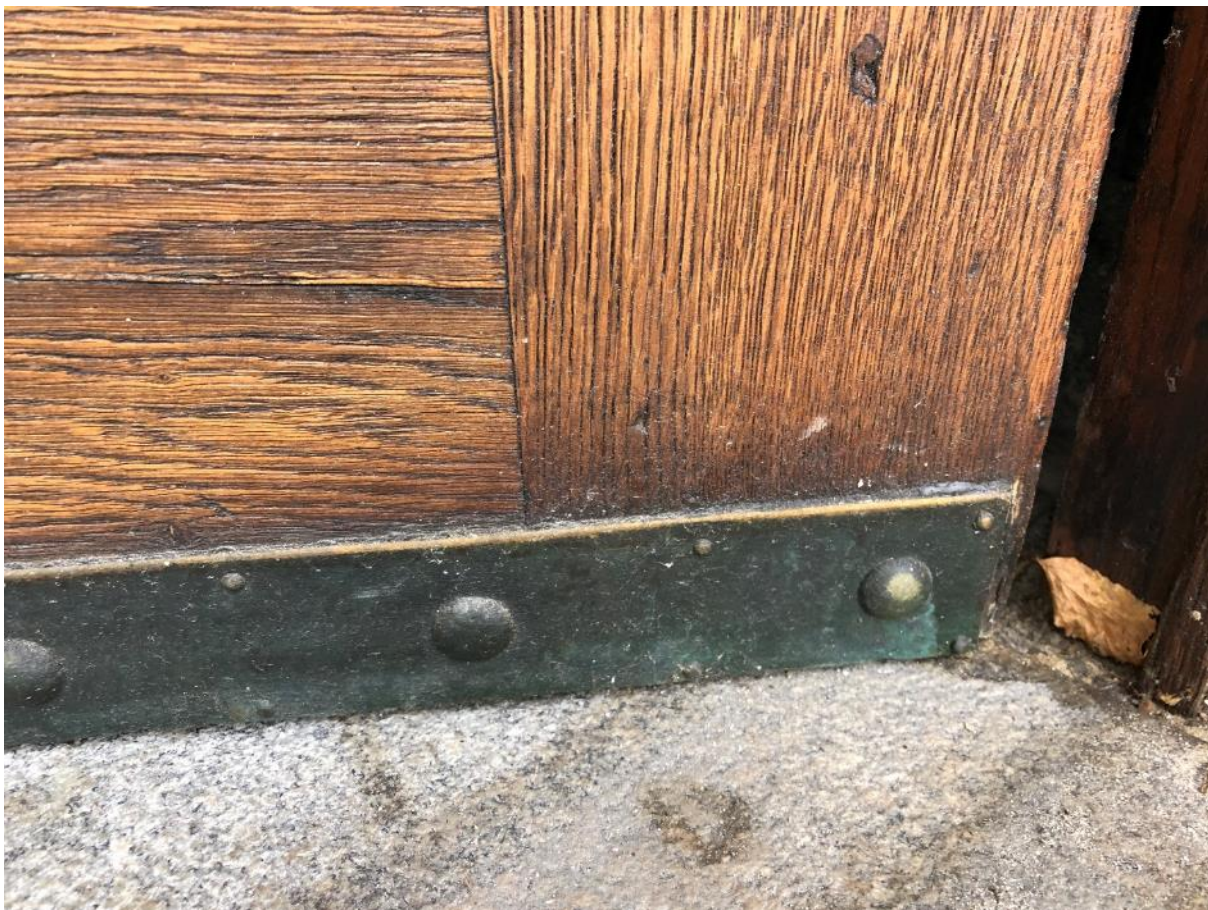
Mosazné olemování spodní části dveří- detail povrchu.
