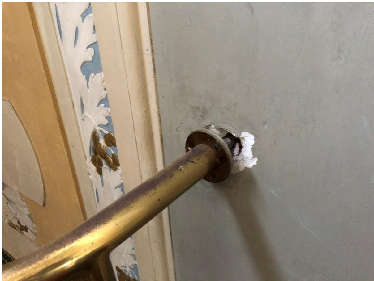
Vytržené kotvení madla trubkového zábradlí na levé straně schodiště.
