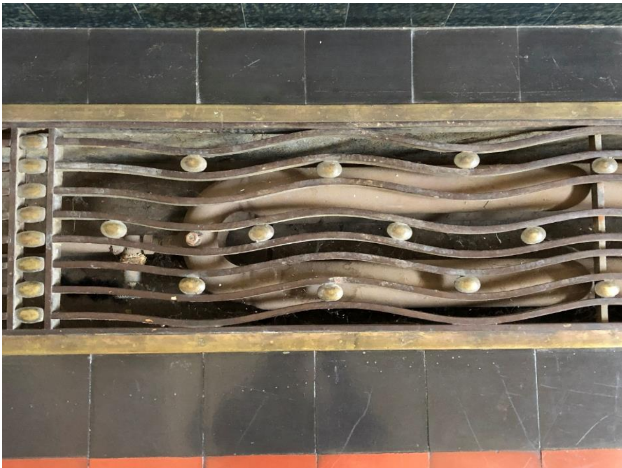
Mřížová konstrukce topení v podlaze
