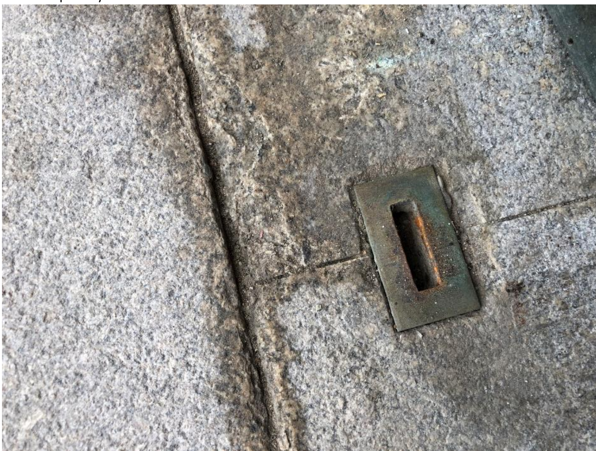
Bronzové orámování otvoru pro zajištění zástrče v podlaze.
