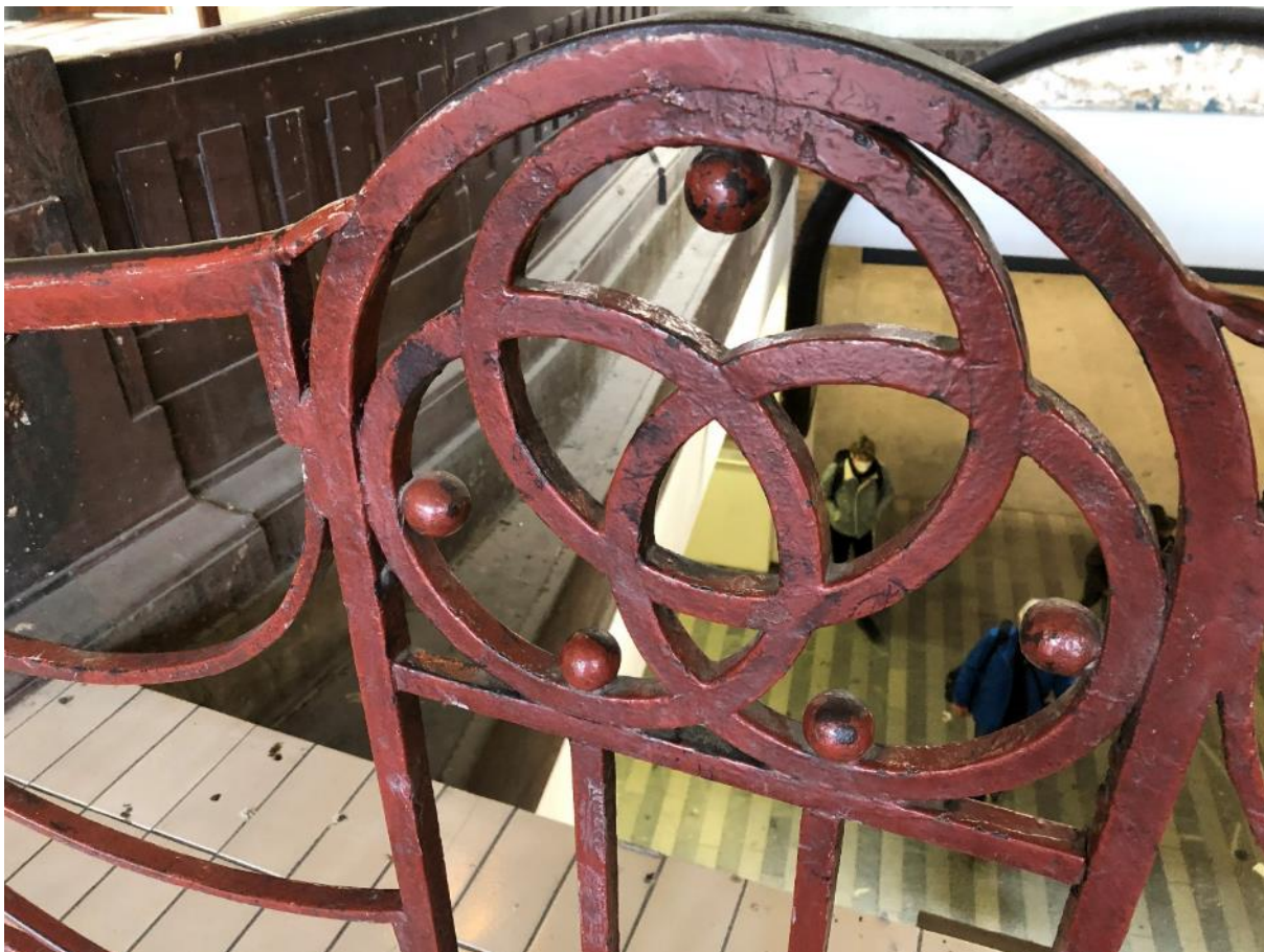
Stav povrchu konstrukce zábradlí.
