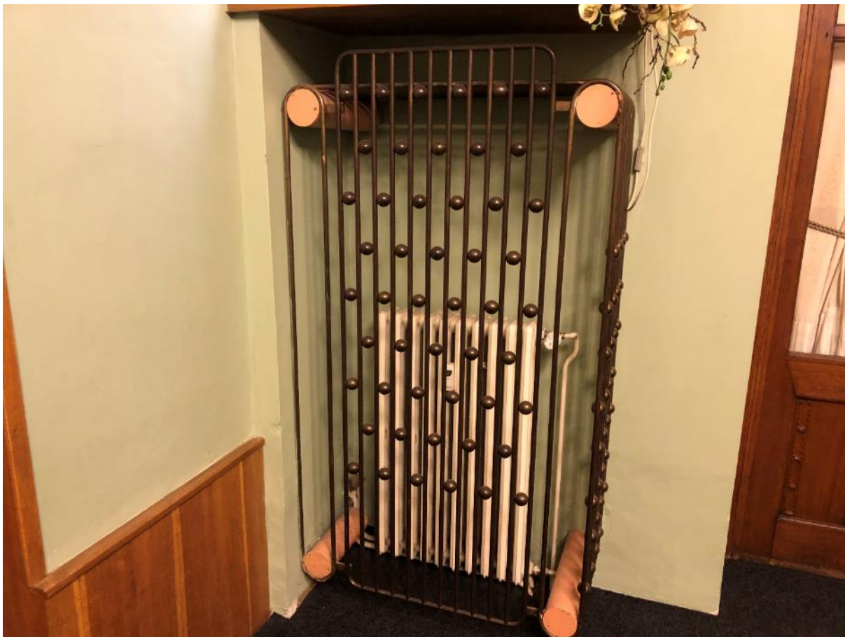
Mosazná trubková konstrukce krytu topení
