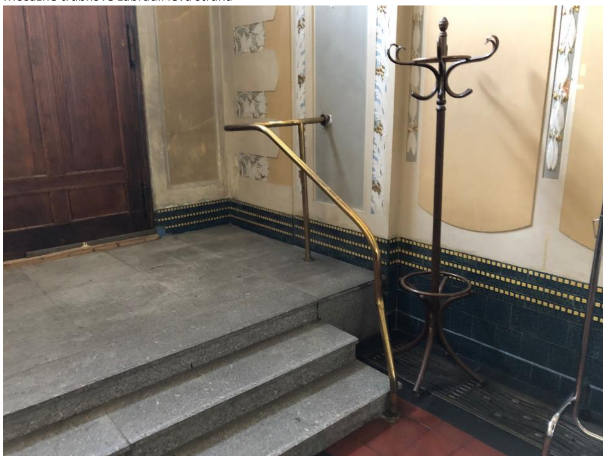
Mosazné trubkové zábradlí pravá strana
