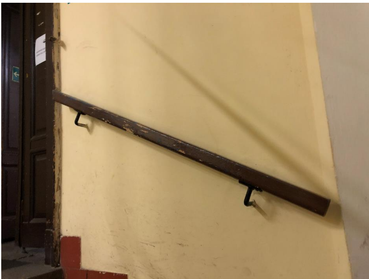
Novodobé konzolky madla zábradlí
