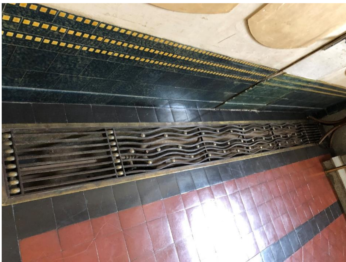
Mřížová konstrukce topení v podlaze
