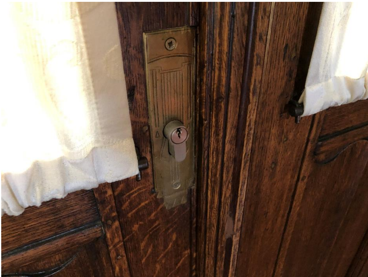
Spodní zámek dveří typu FAB a mosazný štít zámku dveří
