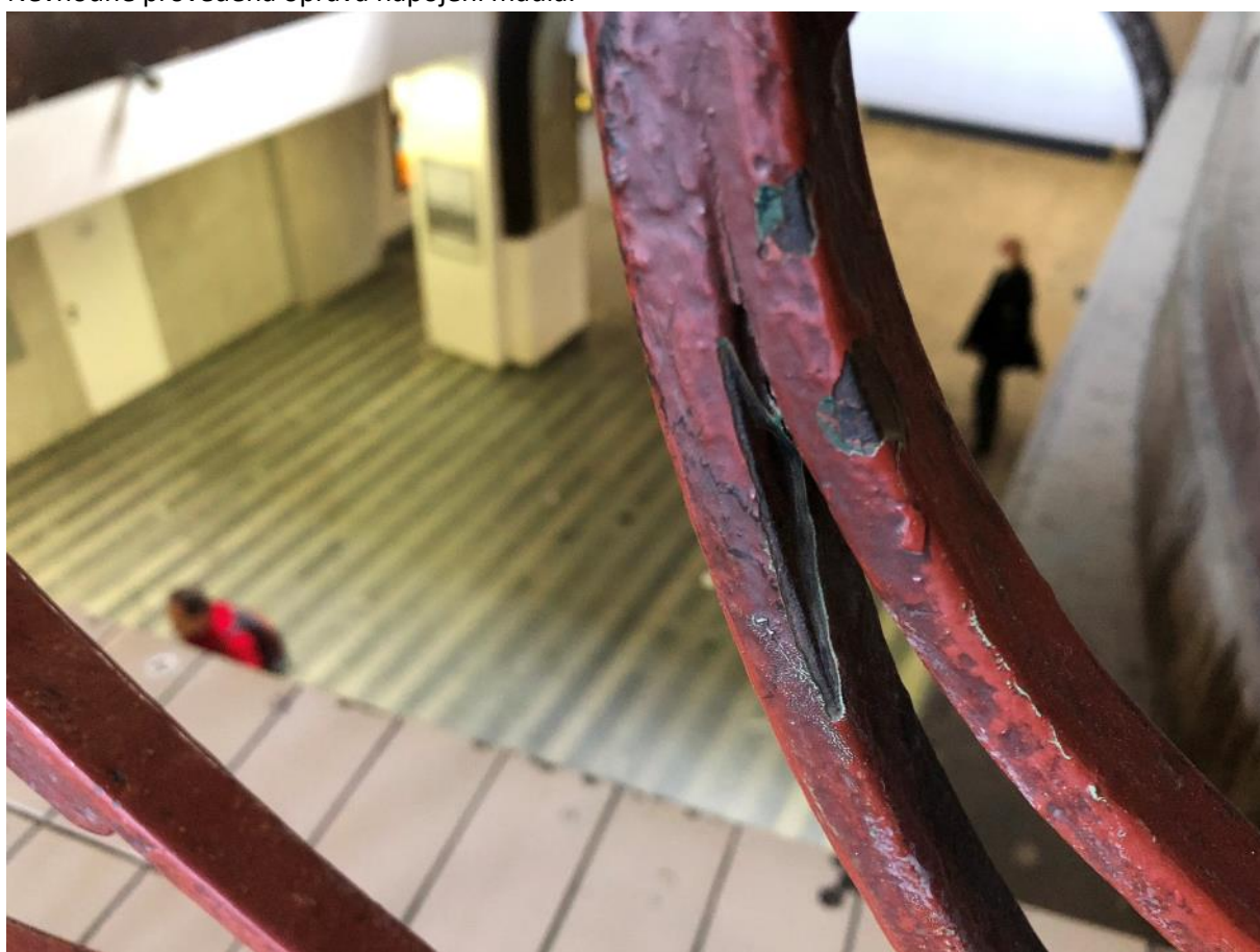
Nevhodně provedená oprava napojení madla.
