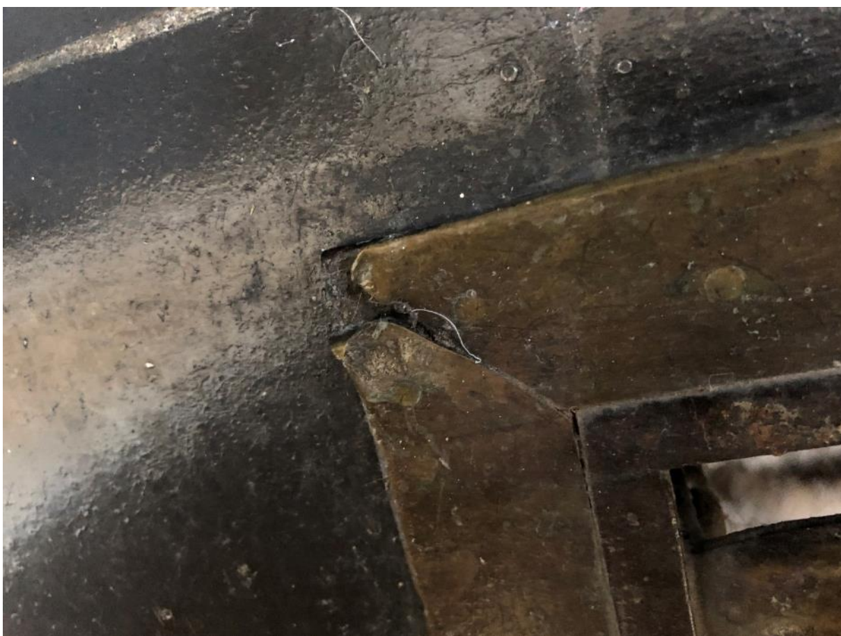
Poškozený mosazný obklad železného úhelníku rámu mříže.
